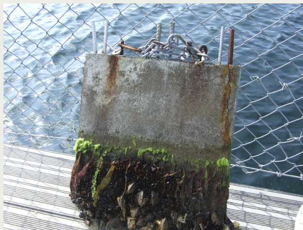
Figur 2. Betongblock (3 % klorider per bindemedelsvikt) med utstickande och oskadad rostfri armering samt en korroderad provstång av kolstål efter två års utomhusexponering.
