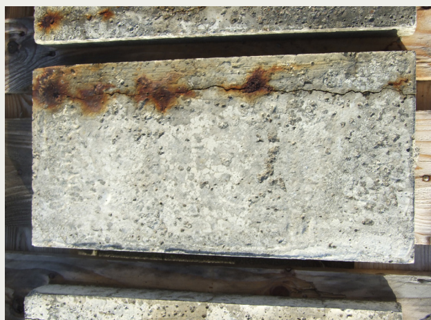
Figur 3. Betongblock med hög kloridhalt (4% klorider per bindemedelsvikt). Betongspricka orsakad av korrosionsprodukter från kraftigt korroderade provstänger av kolstål efter två års utomhusexponering. Inga sprickor på betongen från de rostfria provstängerna kunde konstateras.
